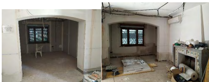
Realización de las obras de acondicionamiento durante 2023
